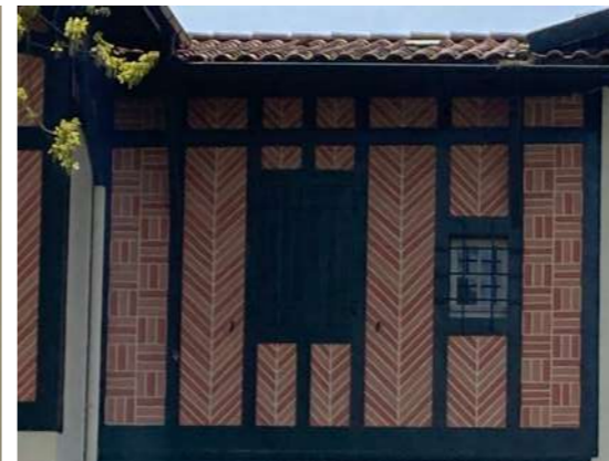
Churruta - Lagrange - faux pan-de-bois maçonnés et fausses briques en feuilles de fougère
