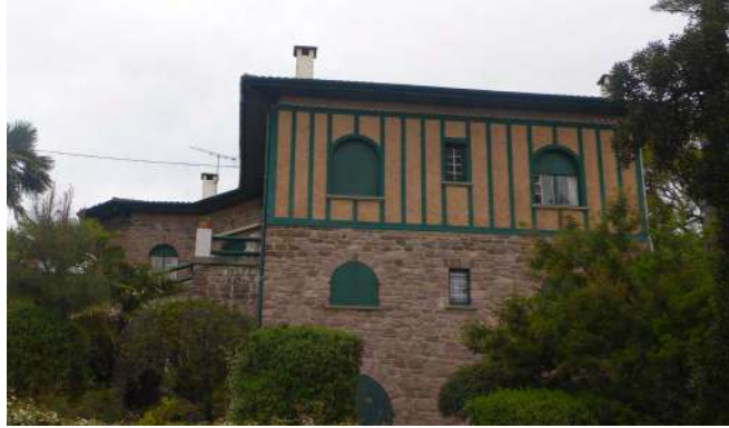
2108 Avenue du Tour du Lac - Les Pierres Roses *
