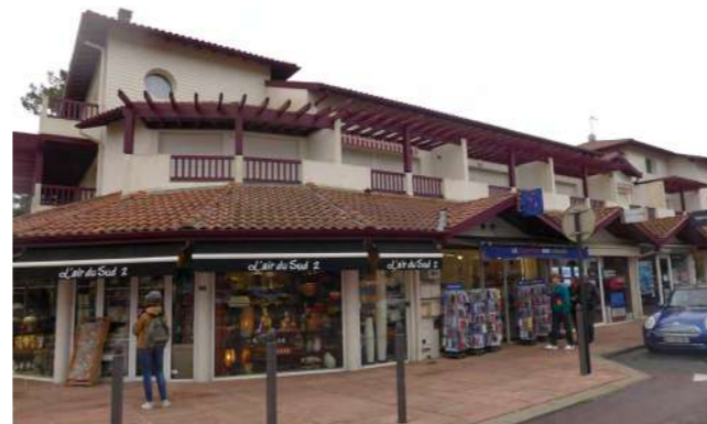
278 à 314 Avenue du Touring Club de France
