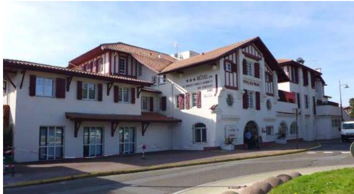
Hôtel du Parc - 911 Avenue du Touring Club de France - Les frères Gomez 1926. Façades côté avenue. *
